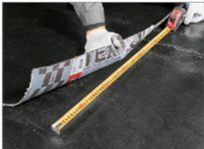
— Второй слой РБМ наплавьте аналогичным способом. Расстояние между краями рулонов в первом и втором слоях должно быть не менее **300 мм**, и обычно составляет **500 мм** (середина рулона).
