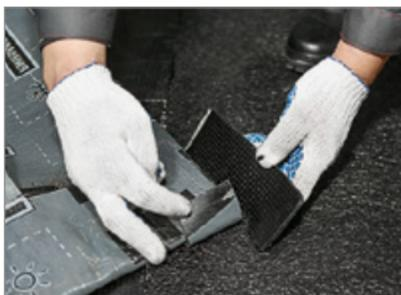
— Переход деформационного шва с вертикали на горизонталь обустройте с помощью специального узла, который выполняется на месте производства работ. Узел стыка состоит из двух частей: верхней (1) и нижней (2).
