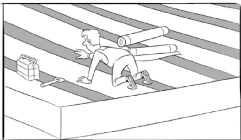
ПОСЛЕ ПРАЙМЕРА ПРОСУШКИ, ЧТО АДГЕЗИЮ УСИЛИТ, НАДО ПРИСТУПИТЬ К УСТРОЙСТВУ УСИЛЯЮЩИХ ПОЛОС. ЭТО ТРУБНЫЕ ПРОХОДКИ, ПЕРЕХОДЫ СНИЗУ НАВЕРХ И ДРУГИЕ СОПРЯЖЕНИЯ ТИПА ВНЕШНЕГО УГЛА.
